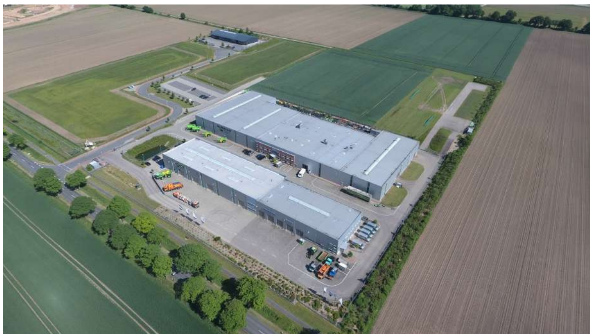
Рис. 1. Производственный комплекс в Бухтехуде-Хедендорф
